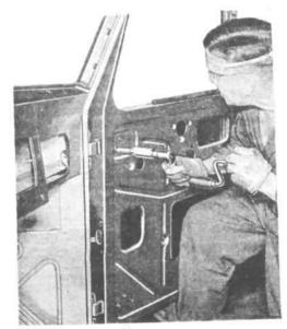
FIG. 303-DOOR HINGE ADJUSTMENT
