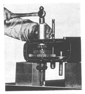
FIG. 213—BEARING CONE DRIVER
