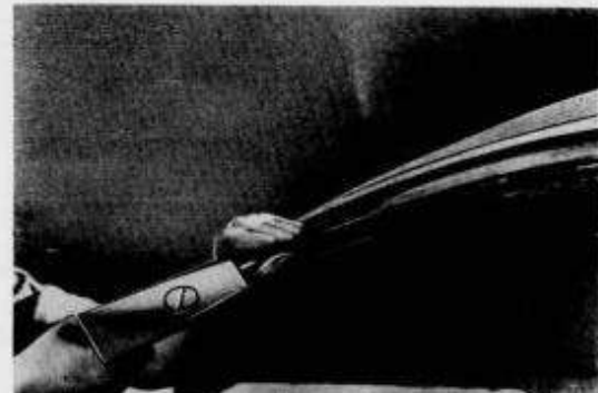
Bild 9. Trennung Windlaufquerstück oben vom Dachvorderteil
