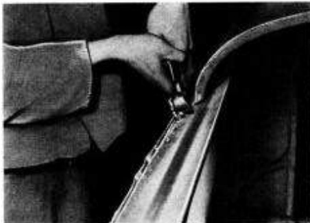
Bild 11. Trennen der alten Punktschweißstelle
